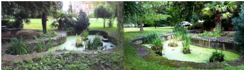
D'environ 40m<sup>2</sup> d'emprise au sol et d'un volume d'environ 20 m<sup>3</sup>, son niveau est maintenu par la collecte d'eau de pluie et par un système de débordement.
